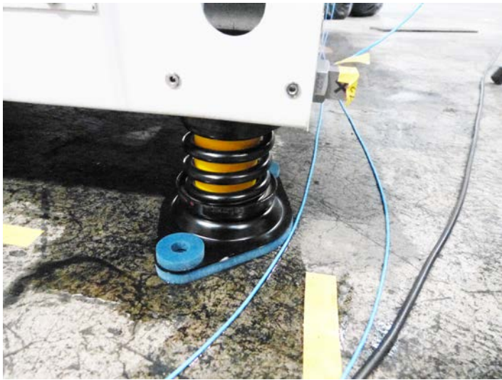
Fig. 3 - La pompa di calore sospesa con antivibrante Isotop DSD con base FP-K
