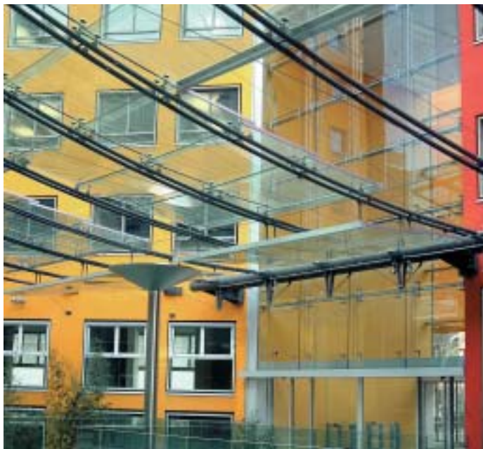
La corte interna è parzialmente coperta da una grande tenda in pannelli di vetro, che ha la duplice funzione di protezione dalla pioggia e dall'irraggiamento solare e di elemento di collegamento tra gli edifici.
